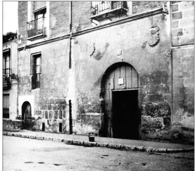
Edificio del edificio del Colegio Velardes antes de su derribo
