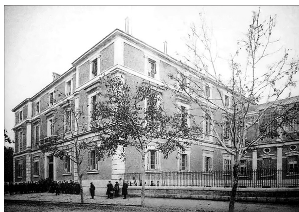
Edificio de la Facultad de Medicina antes de su remodelación en el año 1956
