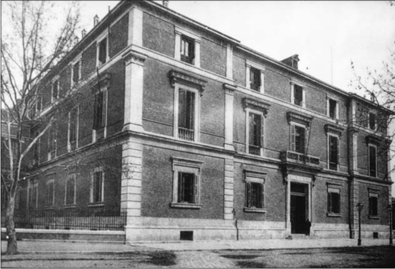
Fachada del edificio de la Facultad de Medicina donde se aprecian sus tres alturas principales, el ático y las ventanas del sótano 1912. Colección fotografías históricas de la Facultad de Medicina.
