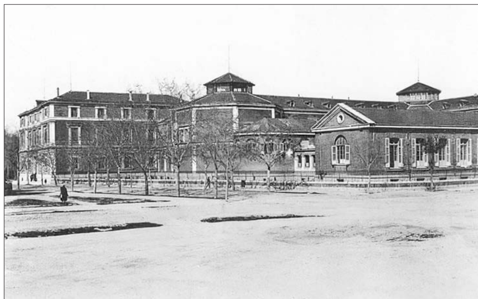
Visión general del Instituto anatómico donde se aprecia la Sala de Disección que corresponde el edificio longitudinal situado en la parte derecha de la fotografía, en la parte central el anfiteatro pequeño y el octogonal en Anfiteatro Grande. Colección fotografías históricas de la Facultad de Medicina.
