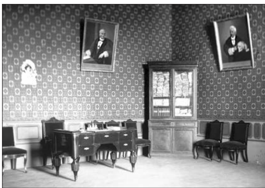
Despacho del Sr. Decano. Fotografía de 1900, tras la inauguración de los Edificios de la Facultad de Medicina y el Hospital Clínico, el 6 de octubre de 1889, siendo Decano Andrés de la Orden y Rector Manuel López Gómez. El Hospital Provincial se había inaugurado días antes el 27 de septiembre de 1889. Colección de fotografías históricas de la Facultad de Medicina.
