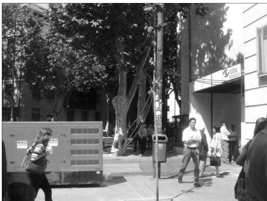
Empleando generadores en el edificio de la Facultad de Medicina tras un corte de suministro eléctrico.
