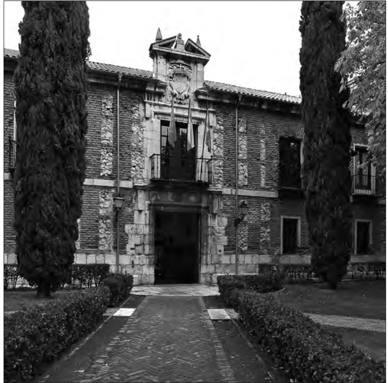
Fachada del edificio del colegio
